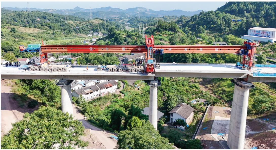
7月14日,最后一孔长32米、重约700吨的箱梁精准落位四川省达州市境内的西渝高铁场坝村跨恩广高速公路大桥桥墩,标志着西渝高铁全线箱梁架设任务顺利完成。 新华社记者 王曦 摄
