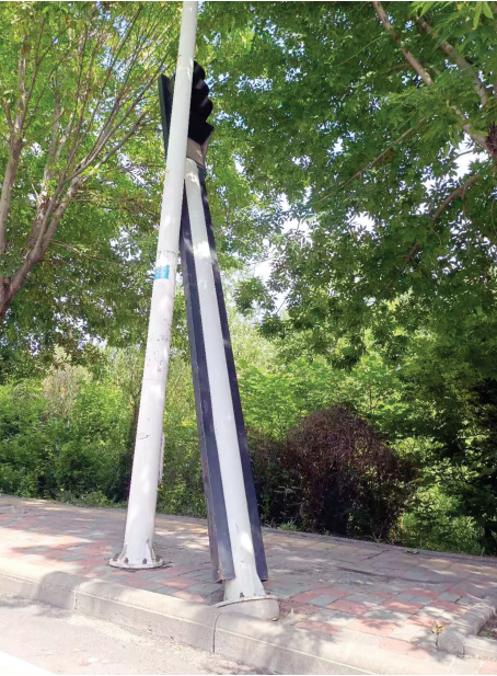
不能正常开启的交通信号灯
