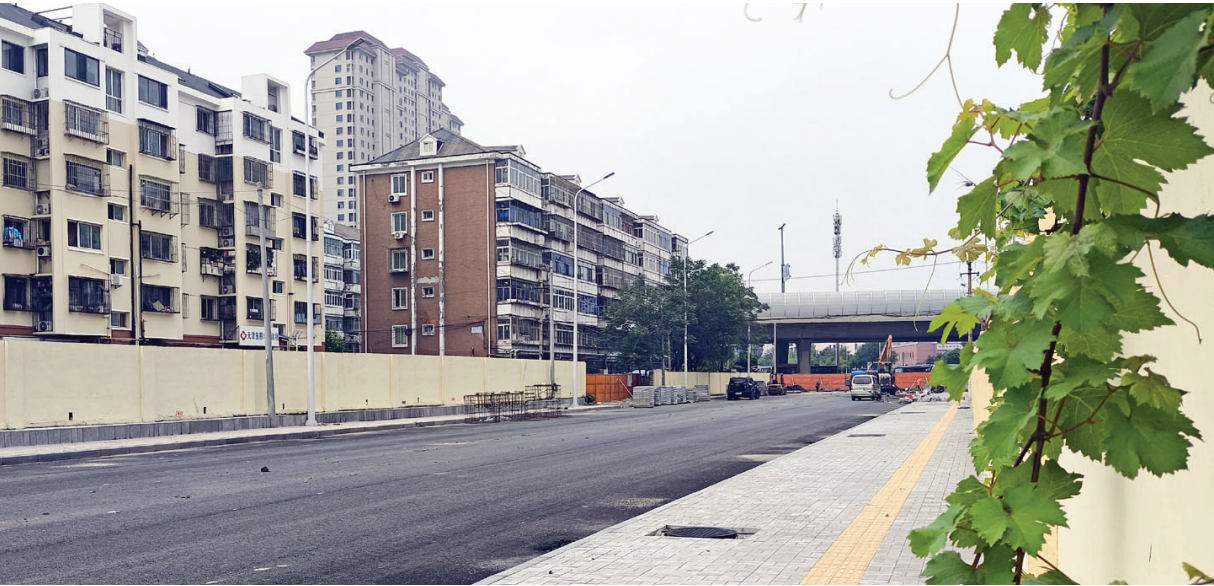
本市东丽区方山道(程万路—昆仑路)即将建成,该条道路建成后可为周边居民提供一条西行直达快速路昆仑桥的便捷通道,有效缓解津滨大道通行压力。 记者 周伟 摄
