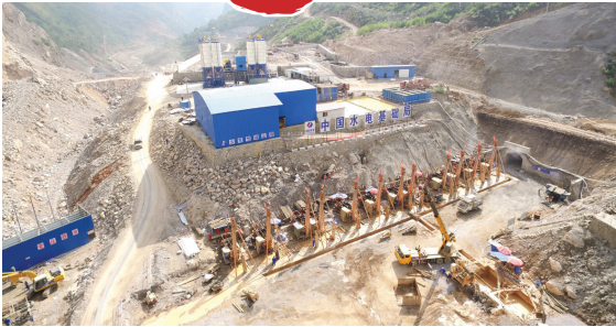
建设期间的航拍现场
