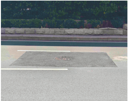
修复好的通信井
