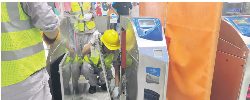
地铁中山门站改造现场
