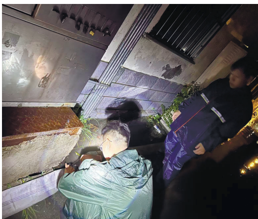
雨夜里,孟阳修补水泵接头
