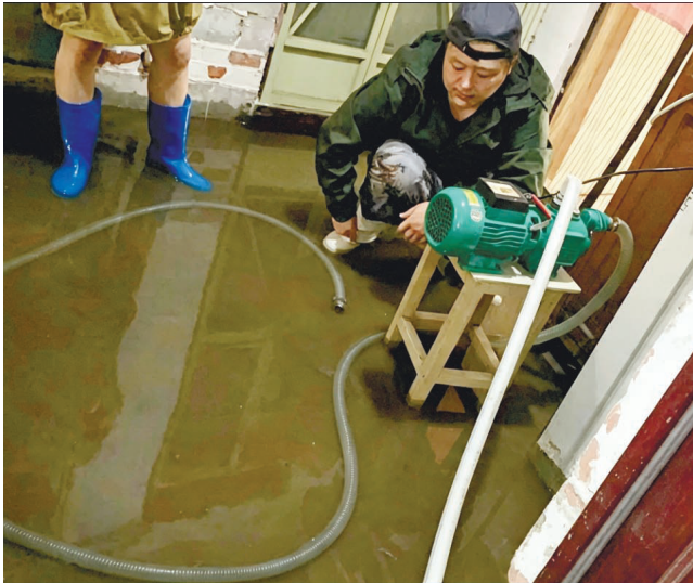
社区工作者使用室内排水泵为居民家里排水
