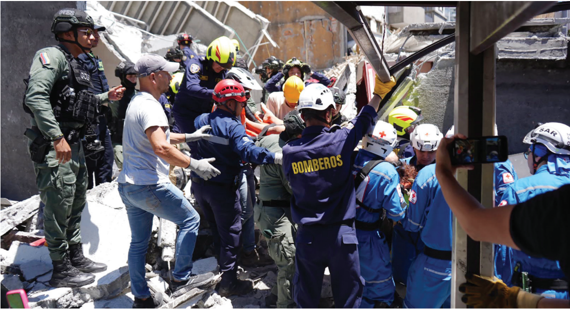
8月10日,救援人员在遭受地震破坏的建筑物废墟上开展救援行动。 新华社发
