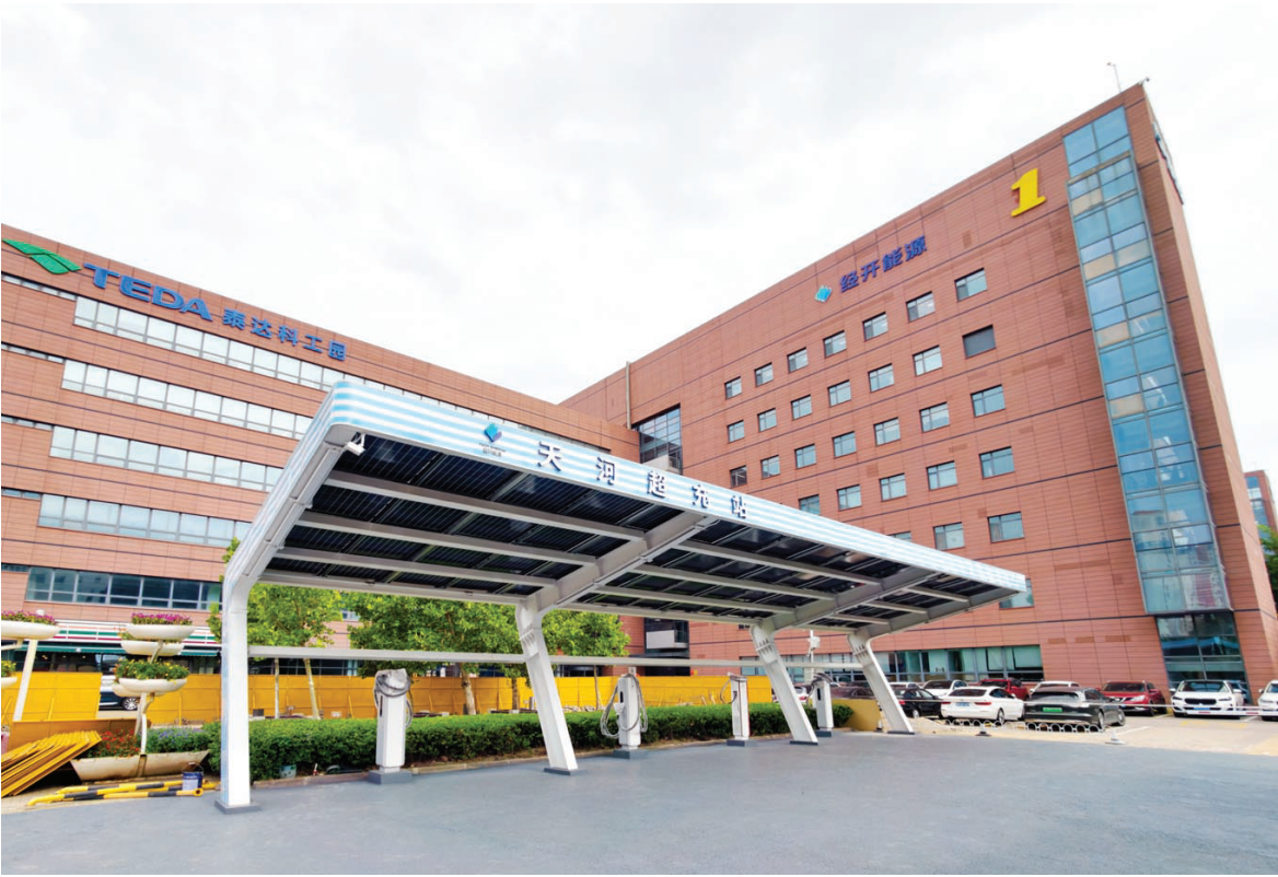
近日,天津经开区天河数字产业园一号楼东侧超充站项目顺利竣工并进入验收调试阶段。
