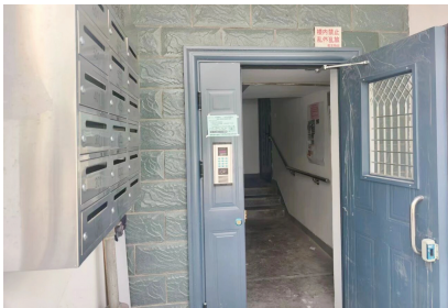
楼道门改造前后
