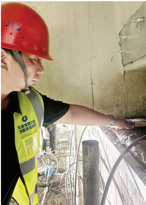
施工人员介绍液压千斤顶如何施工
