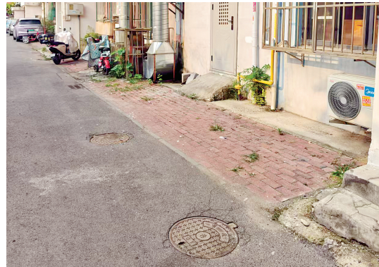
疏通后的污水井
