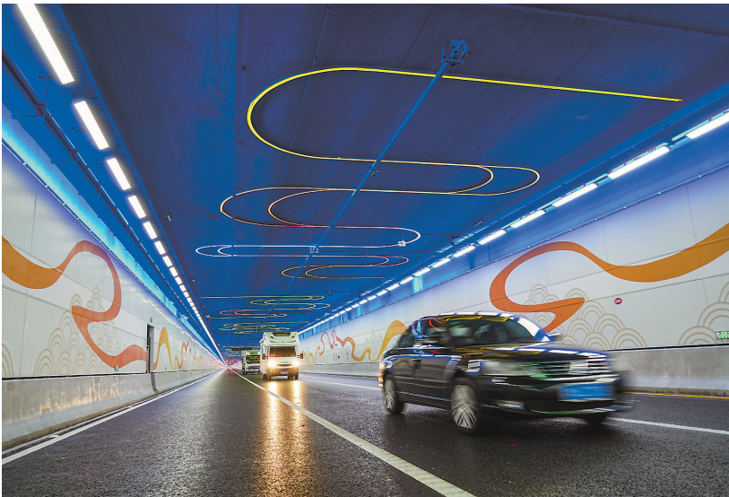
8月25日,由济南城市建设集团投资建设、中铁十四局施工的济南黄岗路黄河隧道建成通车,标志着我国最大直径水下盾构隧道正式投入使用。济南黄岗路黄河隧道全长约5.75公里,其中盾构段长约3.3公里,采用开挖直径达17.5米的“山河号”盾构机施工。隧道为单洞双层结构,上下层共设置六车道,设计时速60公里,是国内首条穿黄单洞双层盾构隧道。左图为车辆行驶在济南黄岗路黄河隧道内。
