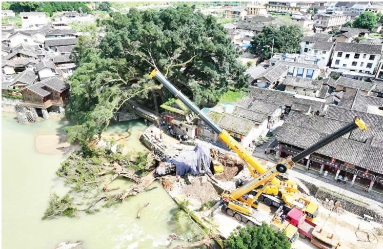
9月8日,在漳州南靖云水谣景区,大型吊车在吊装扶正古榕树(无人机照片)。 新华社发(韩佳镔 摄)
