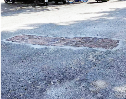
修整后路面恢复平整
