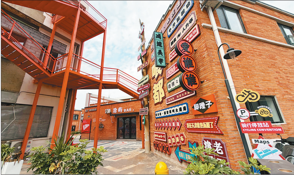
天津骑行文创街区依托原天津市第三自行车零件厂旧址改造而成,保留了老地 砖、旧排风口等工业印记,将1958年投产的老厂房转化为城市新空间,成为市民又 一打卡热门景点。 记者 王倩 摄
