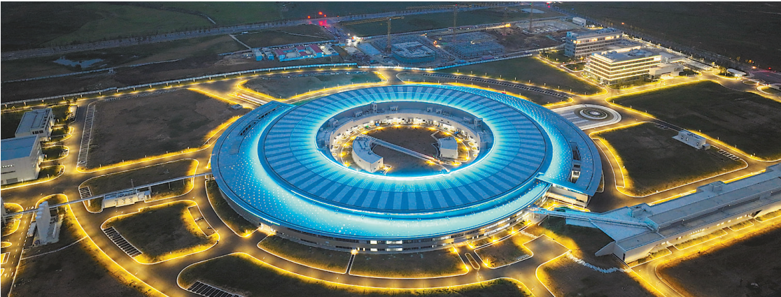
9月20日,随着启动键按下,坐落于安徽合肥未来大科学城的合肥先进光源(HALF)直线加速器成功实现出束,标志着这一国家重大科技基础设施项目建设迈出关键一步。图为9月16日拍摄的建设中的合肥先进光源(HALF)。
