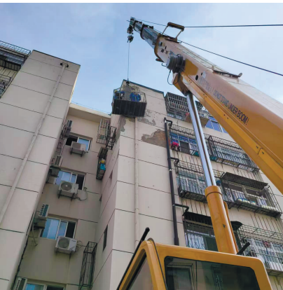
工作人员正在对外墙修补施工
