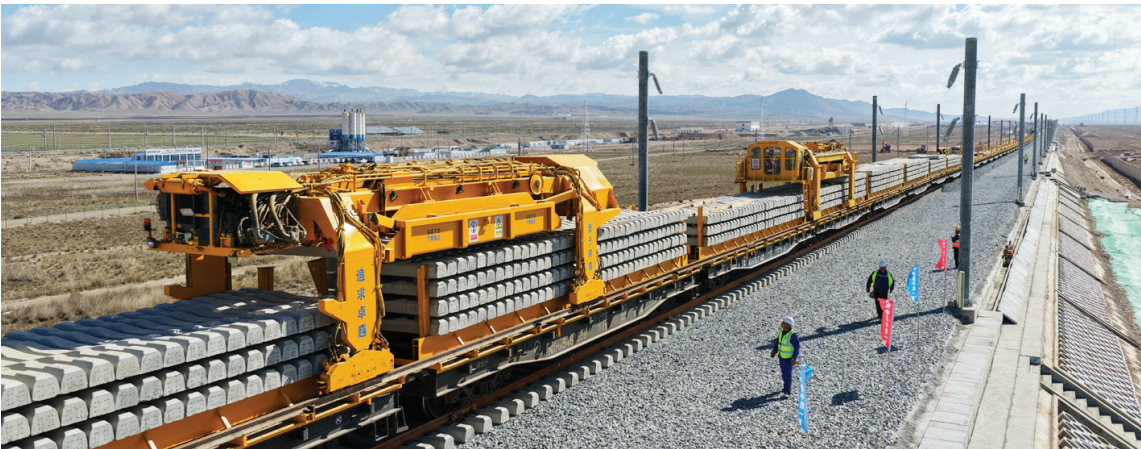
10月9日,兰张高铁在甘肃省张掖市山丹县境内开始长轨铺设,标志着兰张高铁武威至张掖段全面进入铺轨阶段。兰张高铁是国家“八纵八横”高速铁路网陆桥通道和丝绸之路经济带快速客运通道的重要组成部分。 新华社发(宋佳龙 摄)
