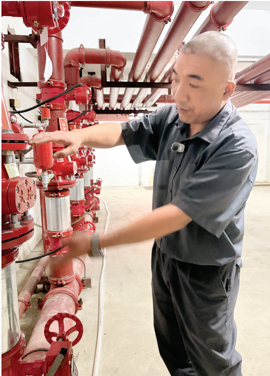
消防控制室内更换的湿式报警阀
