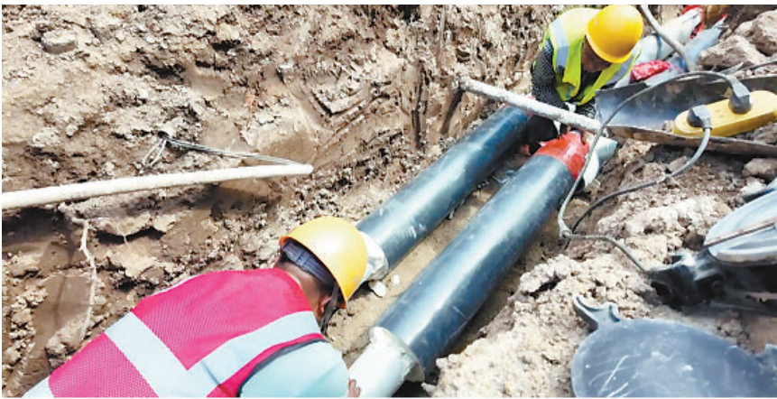
民心工程改造现场
