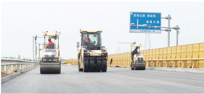
修缮工程顺利完工
