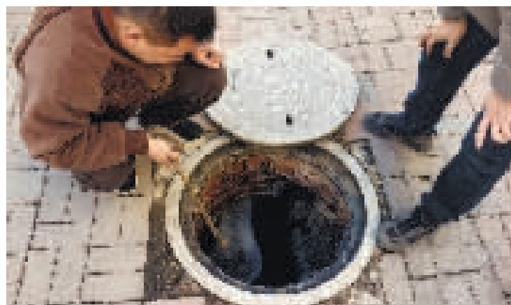
工作人员开展污水疏通作业 图片由社区提供
