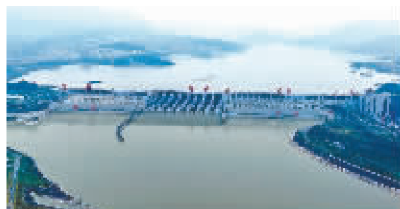
蓄水后的三峡大坝(无人机照片)
