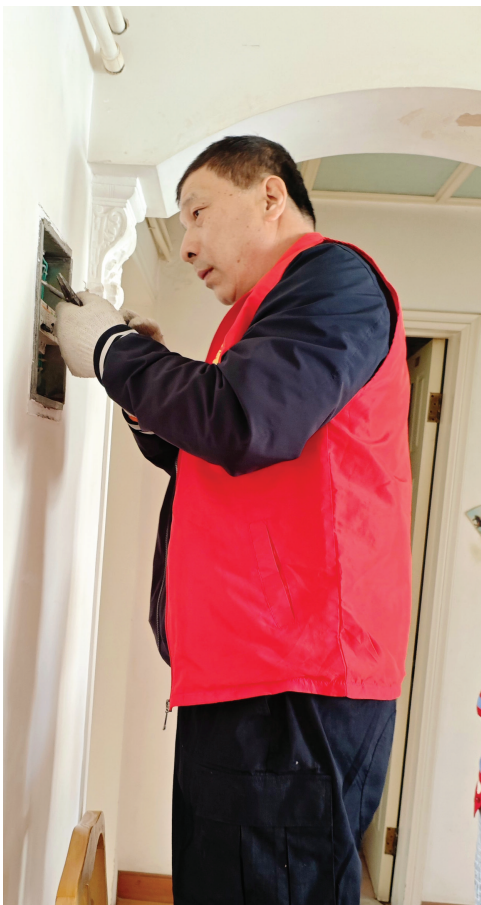
志愿者细心检修居民家中电闸线路。
