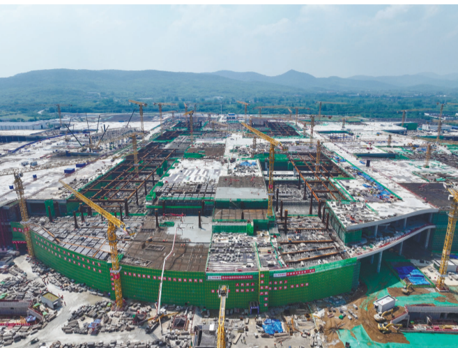
4月30日拍摄的南京北站建设现场(无人机照片)
