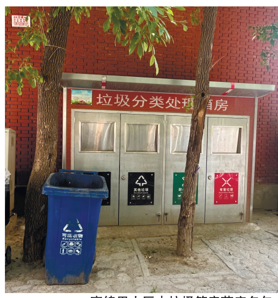
富锦里小区内垃圾箱房荒废多年。
